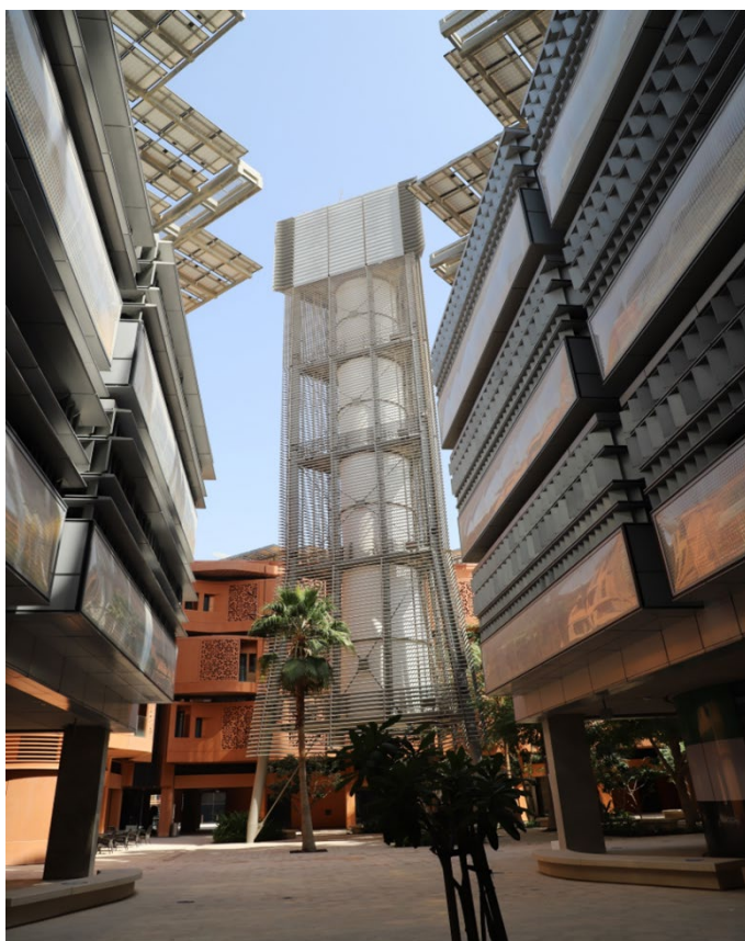
Fot. 2 Wieża chłodząca w Masdar City, Foster and Partners, 2016.
