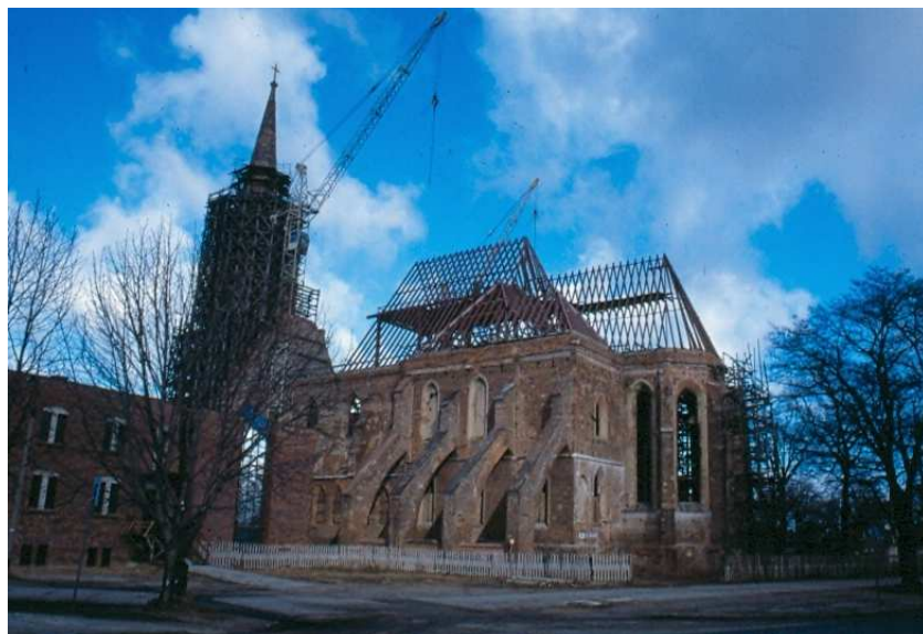
Budowa stalowego dachu w 2000 r.
