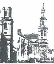
Kościół p.w. Św. Trójcy po odbudowie
