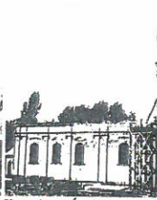
Kościół p.w. Św. Trójcy w trakcie remontu/odbudowy
