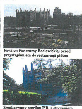
Pawilon Panoramy Racławickiej przed przystąpieniem do restauracji płótna
