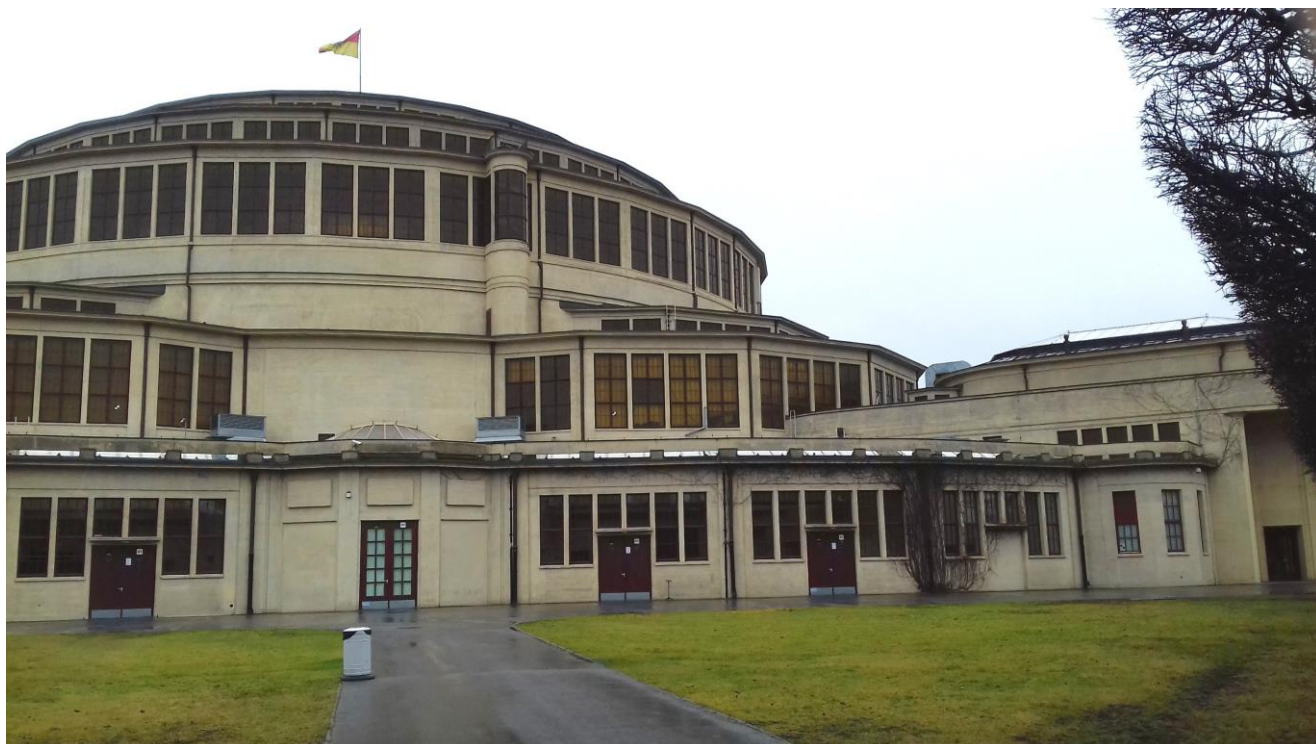
Rys.24 Widok elewacji Hali Stulecia we Wrocławiu, po renowacji elewacji – fot. Leszek Konarzewski
