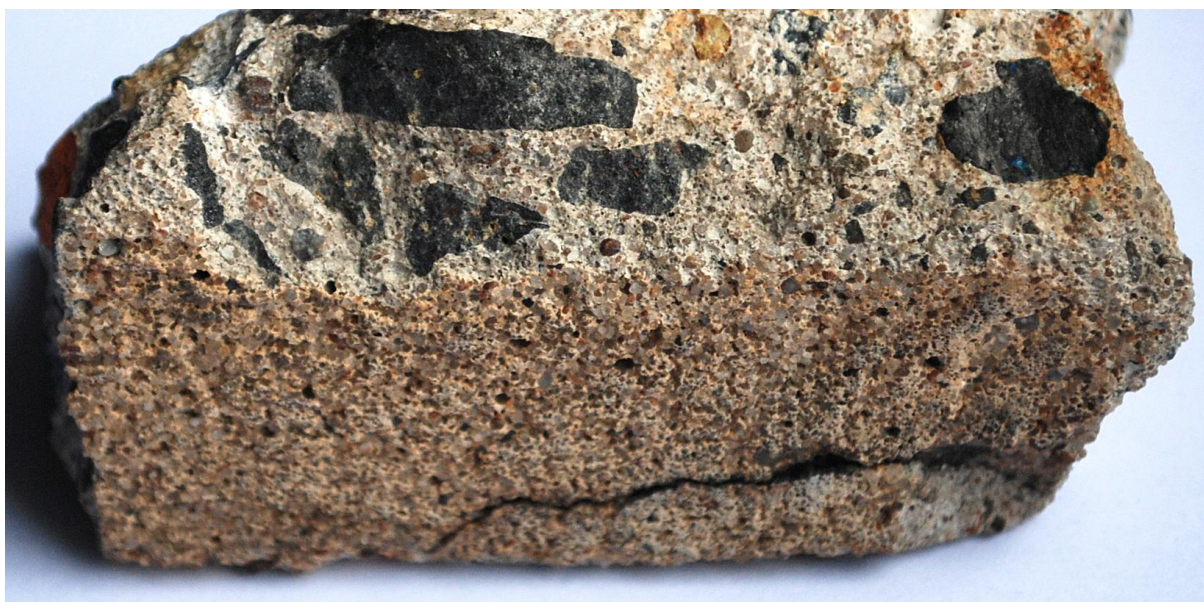
Fot.4. Próbką betonu z elewacji z przed renowacji z widoczna warstwą ochronną
