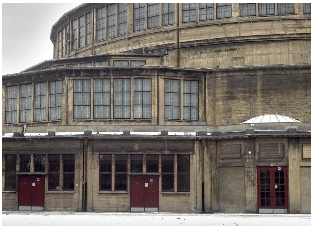
Fot.3. Widok fragmentu ściany Hali Stulecia we Wrocławiu przed renowacją elewacji
