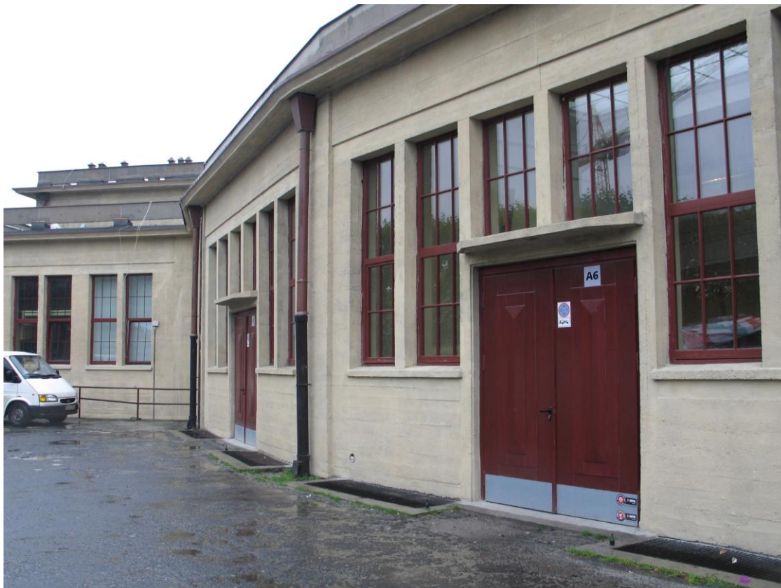
Fot.6. Widok ściany Hali Stulecia po renowacji
