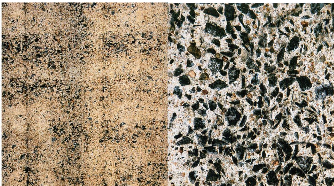
Fot. 2. Widoki w kolejnym zbliżeniu ściany Hali Stulecia we Wrocławiu przed renowacją elewacji
