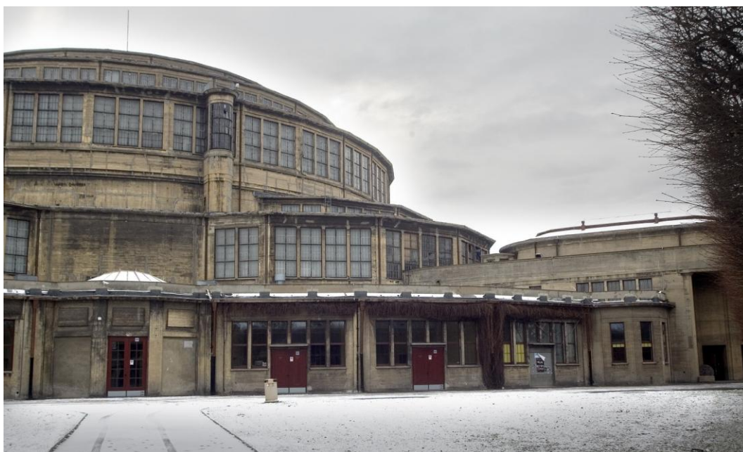
Fot.1. Widok ściany Hali Stulecia we Wrocławiu przed renowacją elewacji
