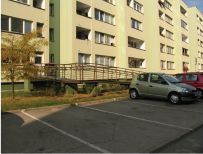
Ryc. 1. Wrocław, Osiedle Bartoszowice, widok pochylni dla osoby niepełnosprawnej prowadzącej do mieszkania na parterze, obok miejsce postojowe, u góry stan w roku 2006, u dołu stan w roku 2014 (źródło: fot. autor)
